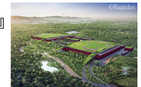
北海道千歳市に建設予定の半導体工場 完成イメージ ©Rapidus
